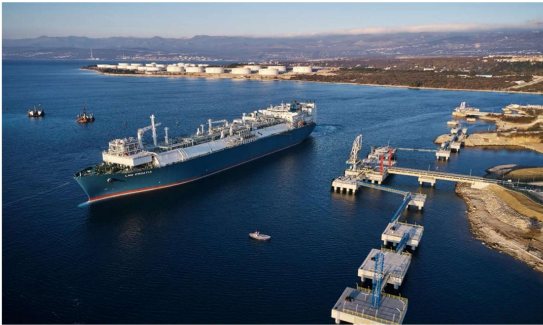
Slika 2-1 UPP terminal na Krku (LNG Hrvatska, 2022a)
