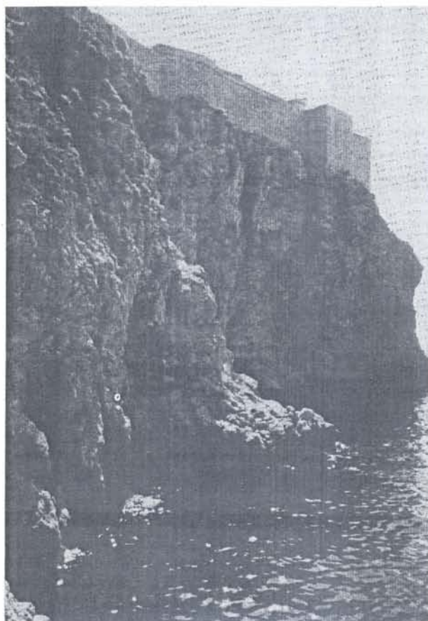
Sl. 5 Obalne stijene u temelju dubrovačkih zidina
