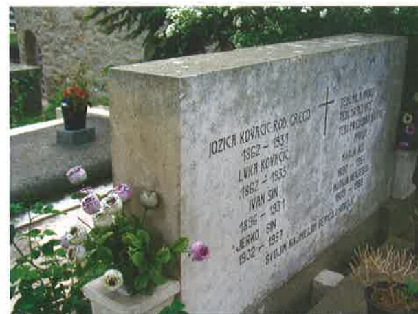
Sl. 4. Groblje u Pučišćima. Prednja strana nadgrobne ploče, povremeno izložena kiši, bez vidljivih je oštećenja (2004.g.)
