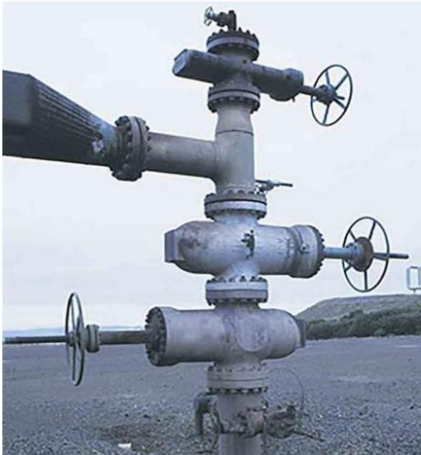
Slika 5-2. Bušotinska glava geotermalne bušotine (Schlumberger, 2020)
