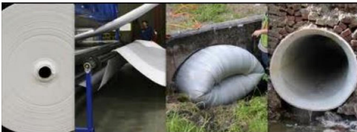
Slika 4-2. Proces izvrtanja u mjestu (Pinter & Associates Ltd., 2013)
