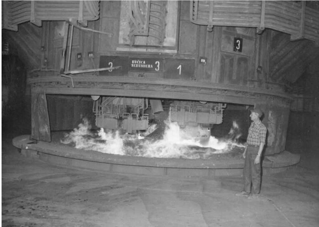
Slika 5-3 Peć za proizvodnju ferolegura (Hrvatska tehnička enciklopedija, 2021)
