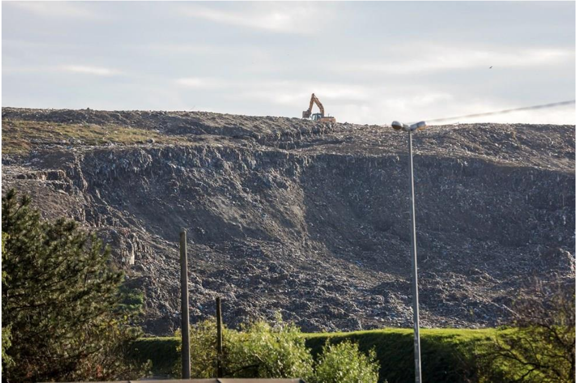
Slika 3-9. Klizište na odlagalištu Prudinec, studeni 2023.godine (Mitrović, 2023)
