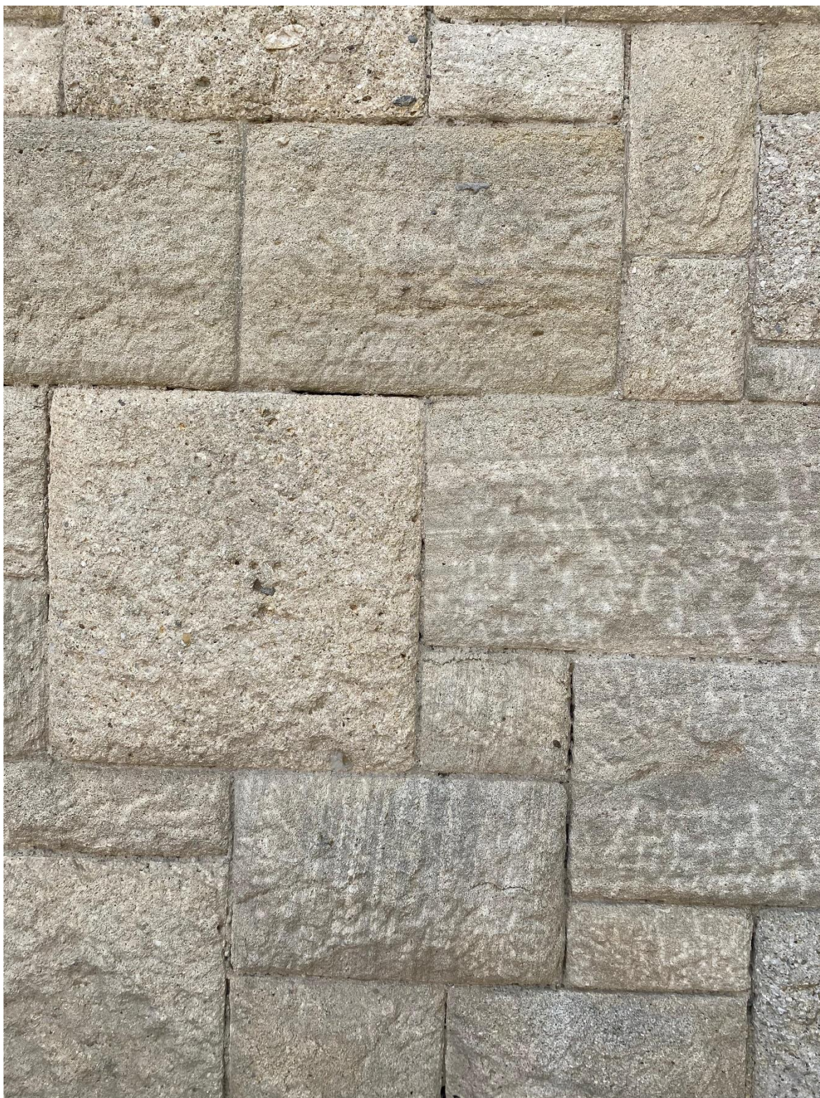
Slika 3-2 Prednji zid Muzeja Sveti Ivan Zelina, obložen kamenim pločama biokalkarenita.
