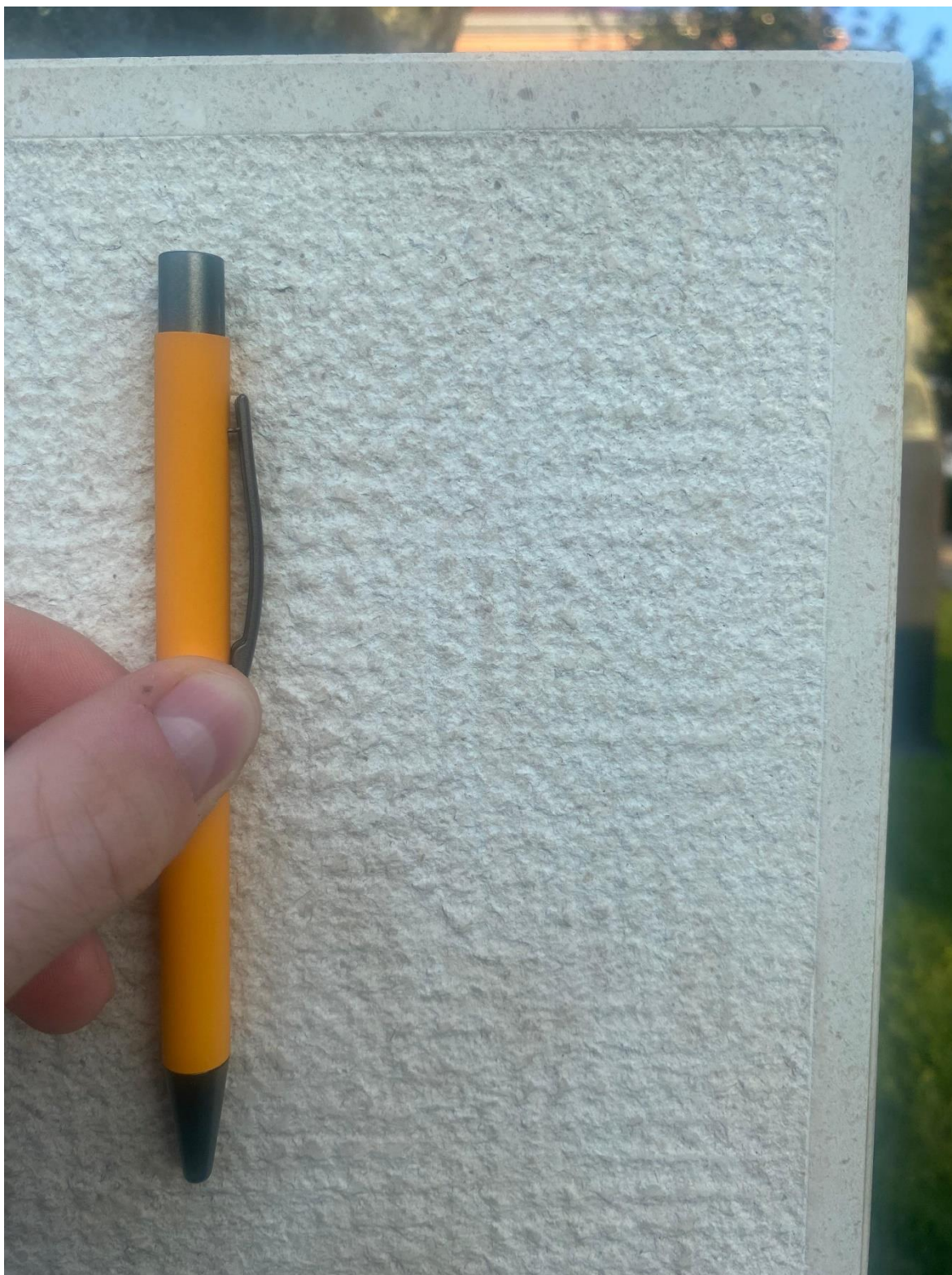
Slika 3-12 Uvećani prikaz kontakta dviju različito obrađenih ploča vapnenca od kojeg je izgrađen spomenik Dragutinu Domjaniću na trgu Ante Starčevića u Svetom Ivanu Zelini. Mjerilo: kemijska olovka duljine 14cm.
