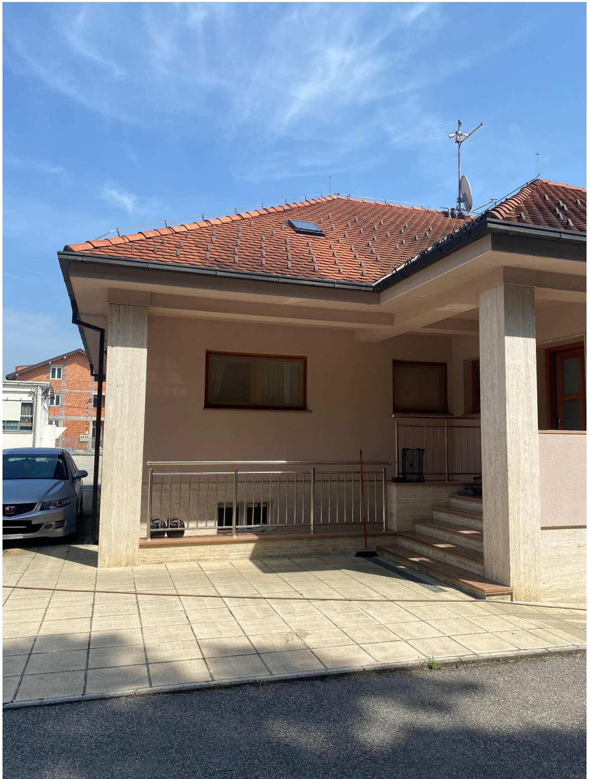
Slika 3-19 Stambena kuća u naselju Goričica, kojoj su temelji i stupovi obloženi travertinom.
