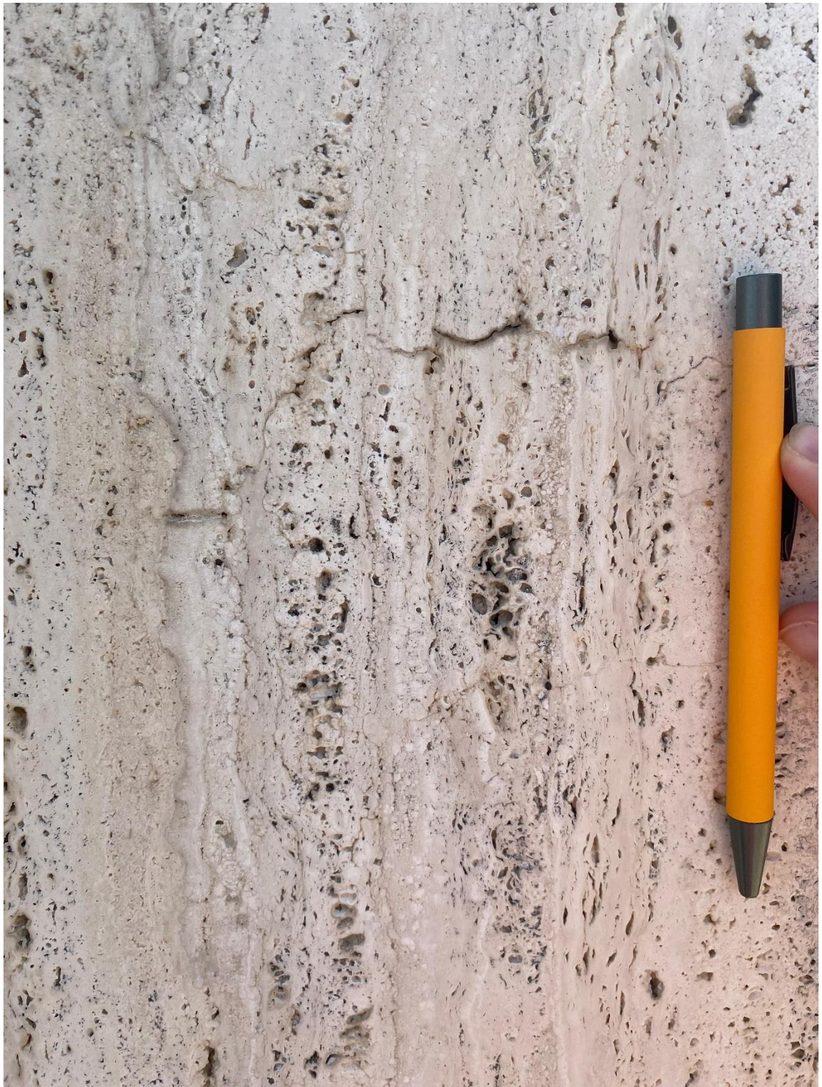
Slika 3-21 Detalj kamene ploče travertina korištene u oblaganju stambene kuće u naselju Goričica. Mjerilo: kemijska olovka duljine 14 cm.
