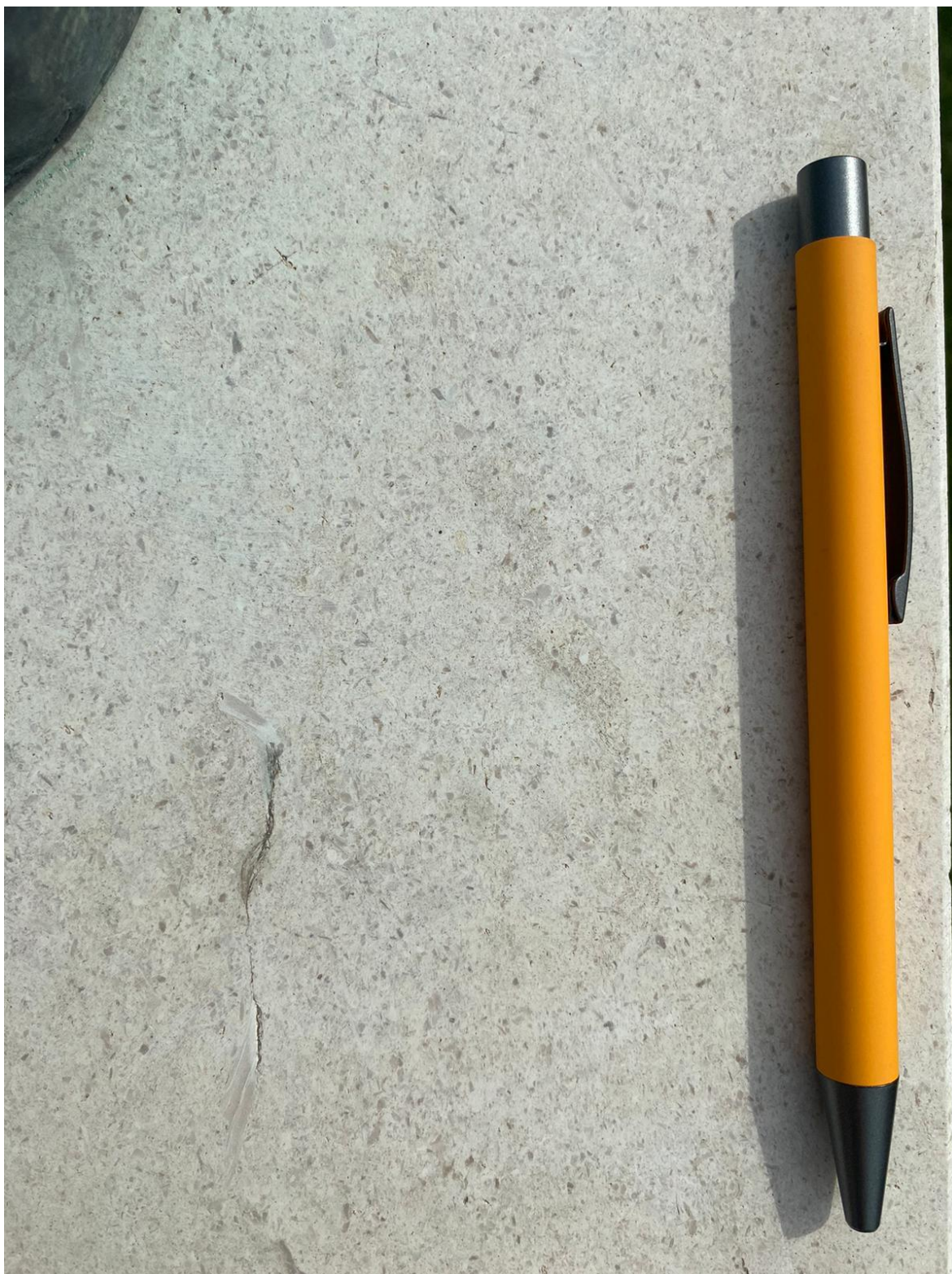
Slika 3-11 Detalj rudistnog vapneca od kojeg je izgrađen spomenik Dragutinu Domjaniću na trgu Ante Starčevića u Svetom Ivanu Zelini. Mjerilo: kemijska olovka duljine 14 cm.
