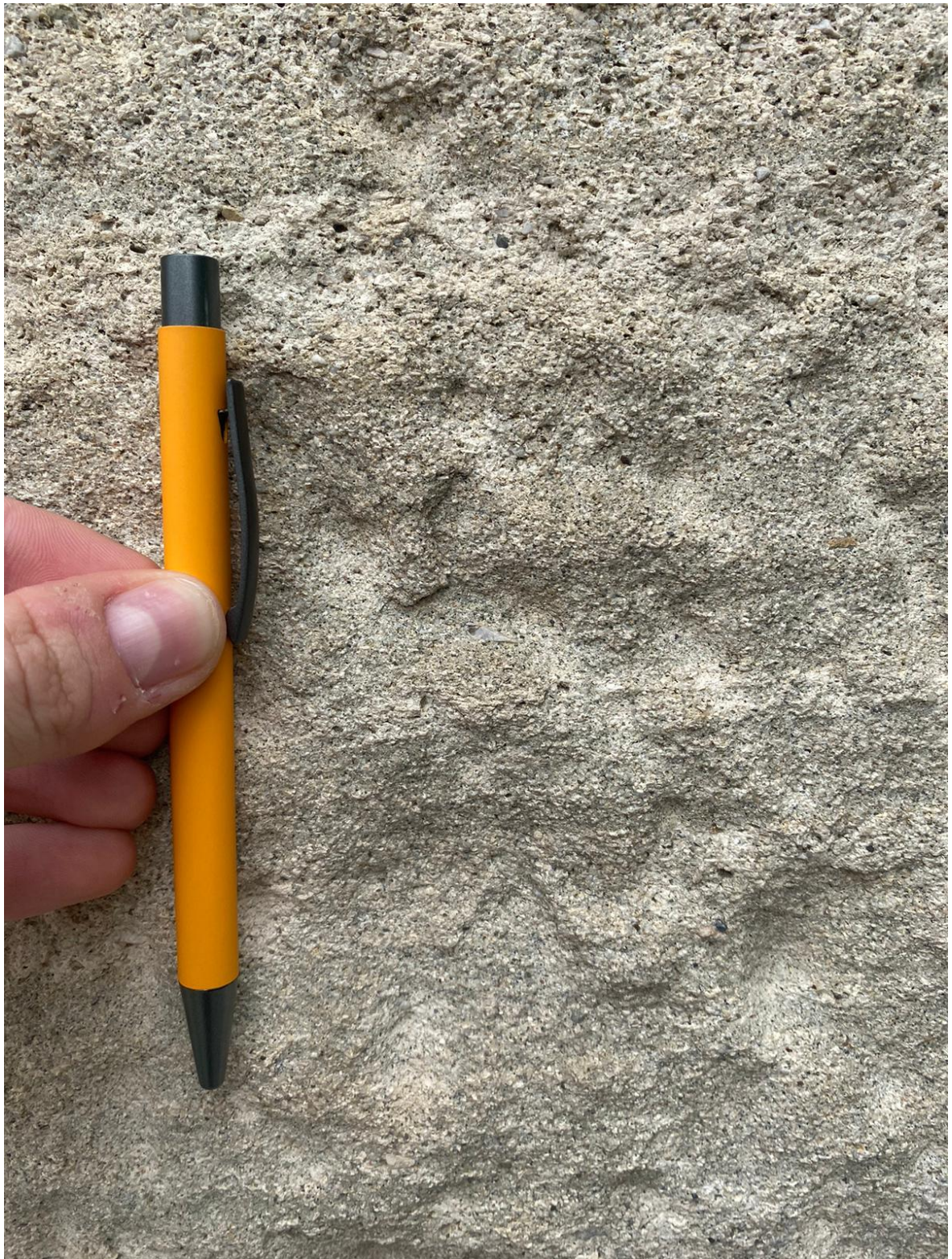
Slika 3-3 Detalj kamene ploče prednjeg zida Muzeja Sveti Ivan Zelina. Vidljiva je laminacija uvjetovana različitom veličinom zrna. Mjerilo: kemijska olovka duljine 14 cm.
