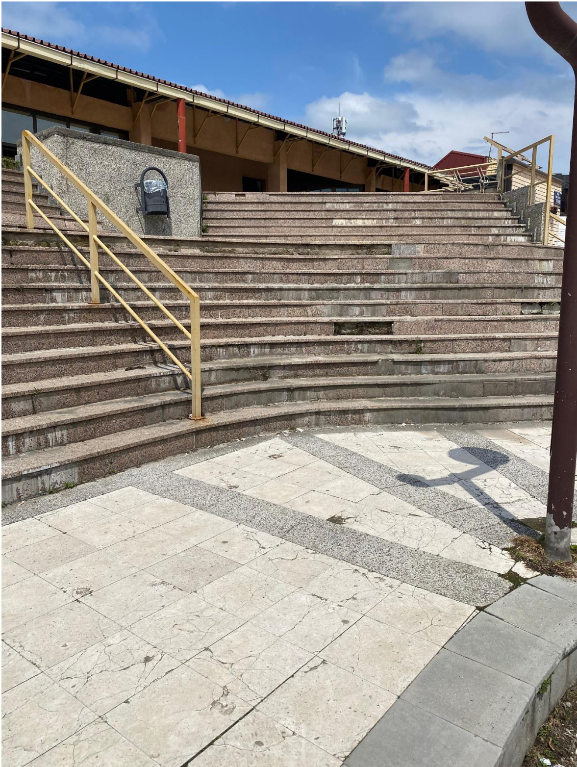
Slika 3-4 Sportska dvorana Sveti Ivan Zelina. Stepenice su obložene granitom s ružičastim alkalijskim feldspatima, dok je prilaz popločen svijetlim varijetetom granita i kamenim pločama vapnenca.
