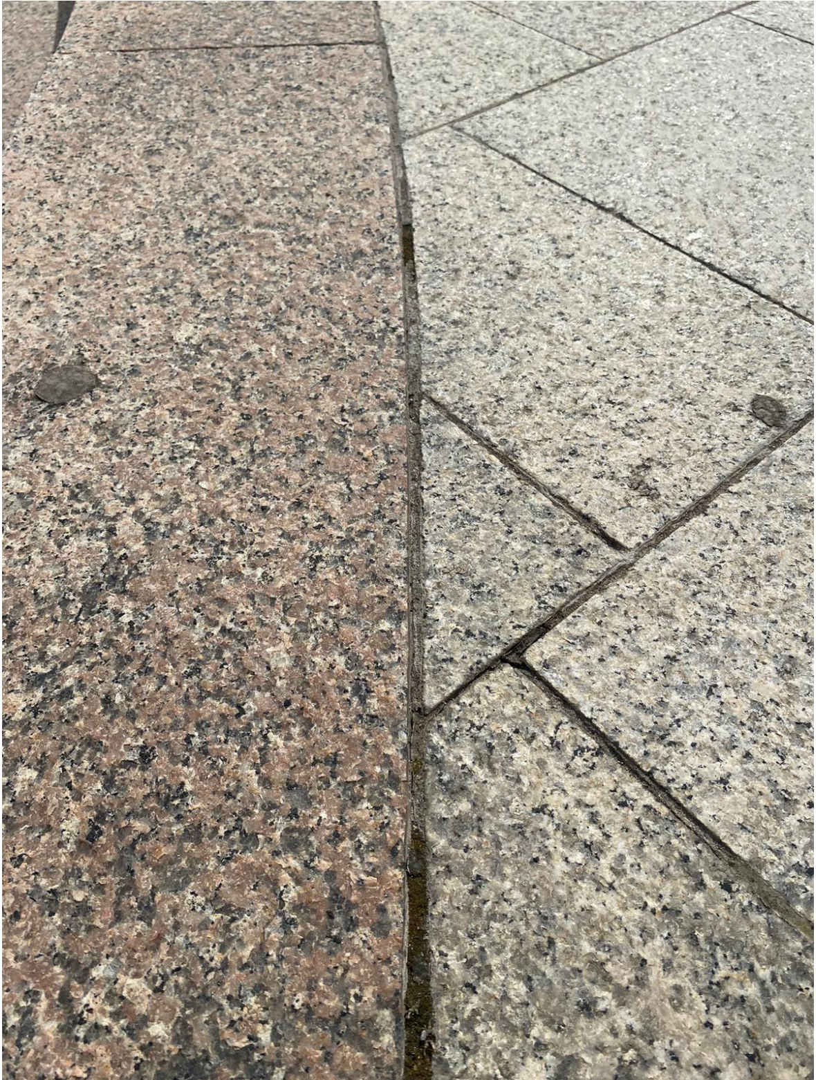
Slika 3-5 Krupni prikaz dvaju kamenih varijeteta granita (ružičastog varijeteta-lijevo i bijelo-sivog varijeteta-desno) stepenica sportske dvorane Sveti Ivan Zelina.
