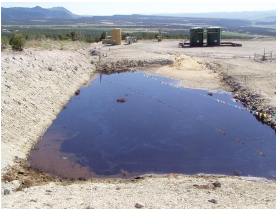
Slika 3-5. Pomoćna otpadna jama uz završenu bušotinu (Ramirez, 2009)
