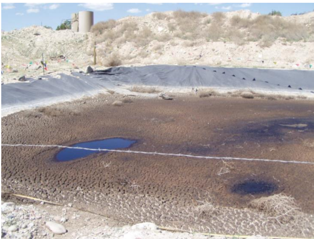
Slika 3-6. Pomoćna otpadna jama nakon isparavanja fluida (Ramirez, 2009)
