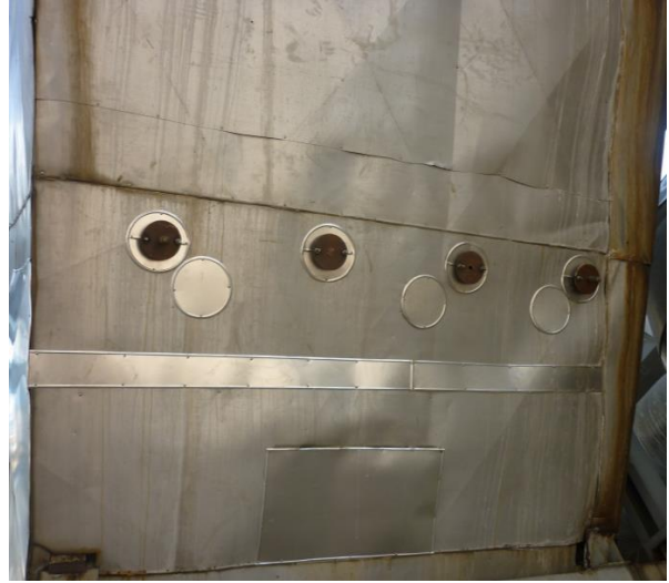
Slika 4-18. Mjerno mjesto (lijevo) i mjerni priključci (desno) kotla K3 (EKONERG d.o.o., 2015).
