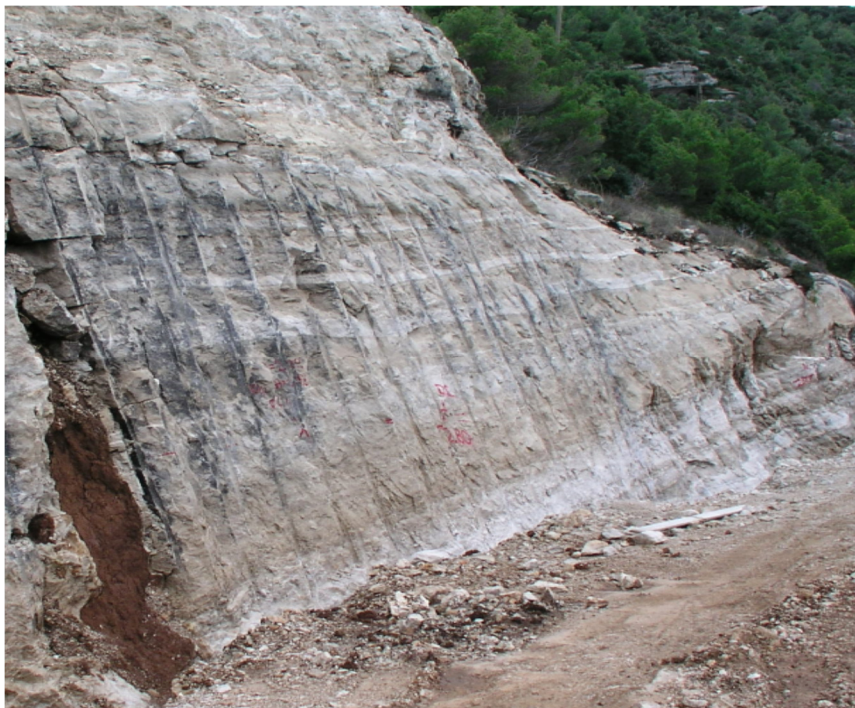
Slika 3-11. Završna kosina izvedena konturnim miniranjem (Dobrilović, 2008).
