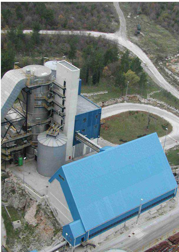
Slika 4-11. Postrojenje za odsumporavanje dimnih plinova (DeSO x ) TEP 2 (Vukelić, 2013.)
