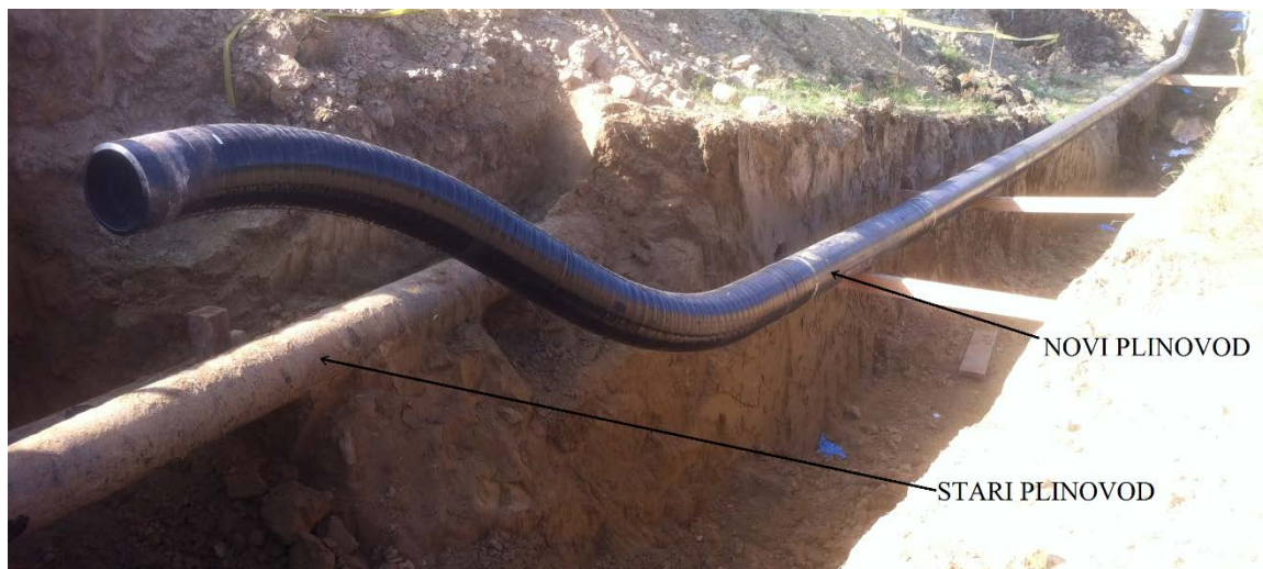
Slika 8-5. Stari i novi plinovod u mjestu Vagovina
