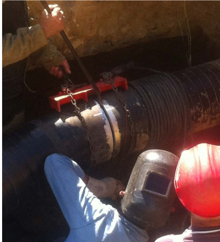
Slika 8-7. Zavarivanje plinovoda u mjestu Vagovina
