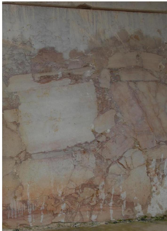
Slika 4-6. Istražna galerija izrađena u prvom produktivnom sloju (karbonatne breče)
