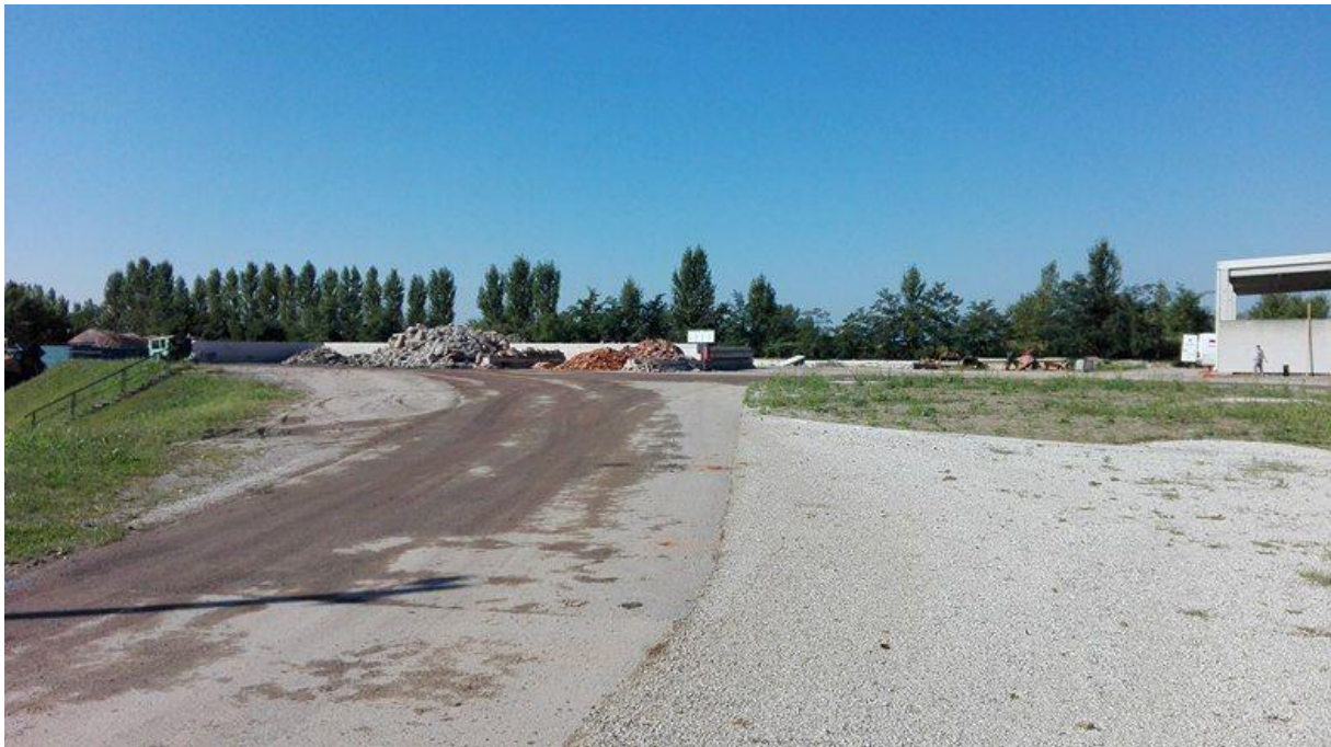
Slika 4-2. Vodnepropusni plato, na kojem se privremeno odlaže i razdvaja građevinski otpad
