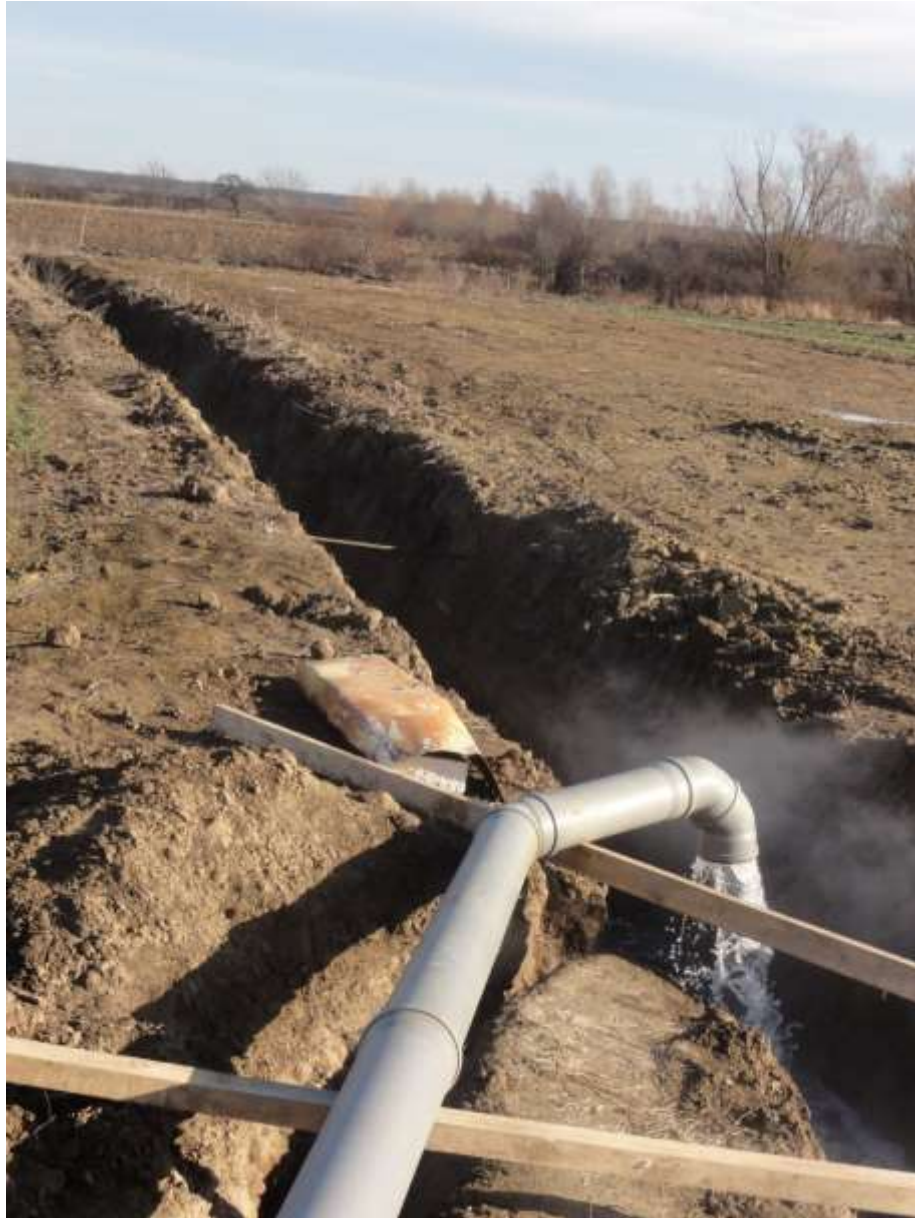
Slika 5-1. Ispuštanje vode u melioracijski kanal
