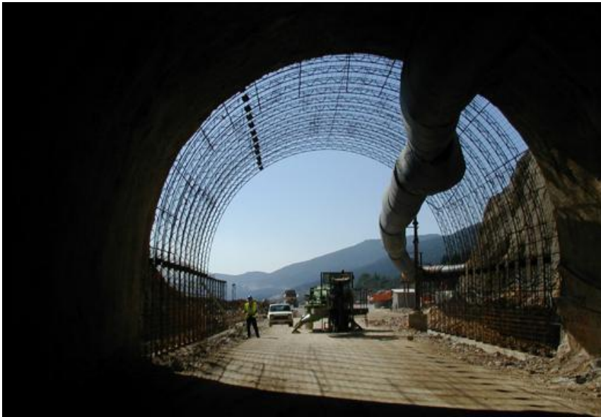
Slika 2-3. Tunel „Plasina“ (GI grupa d.o.o., 2002)
