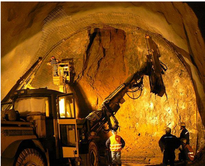
Slika 2-6. Tunel „Sleme“, desna cijev (Viadukt d.d., 2006)
