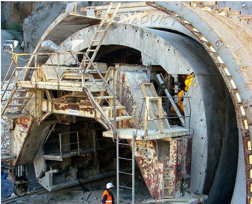
Slika 2-4. Tunel „Škurinje II“ (Viadukt d.d., 2008)
