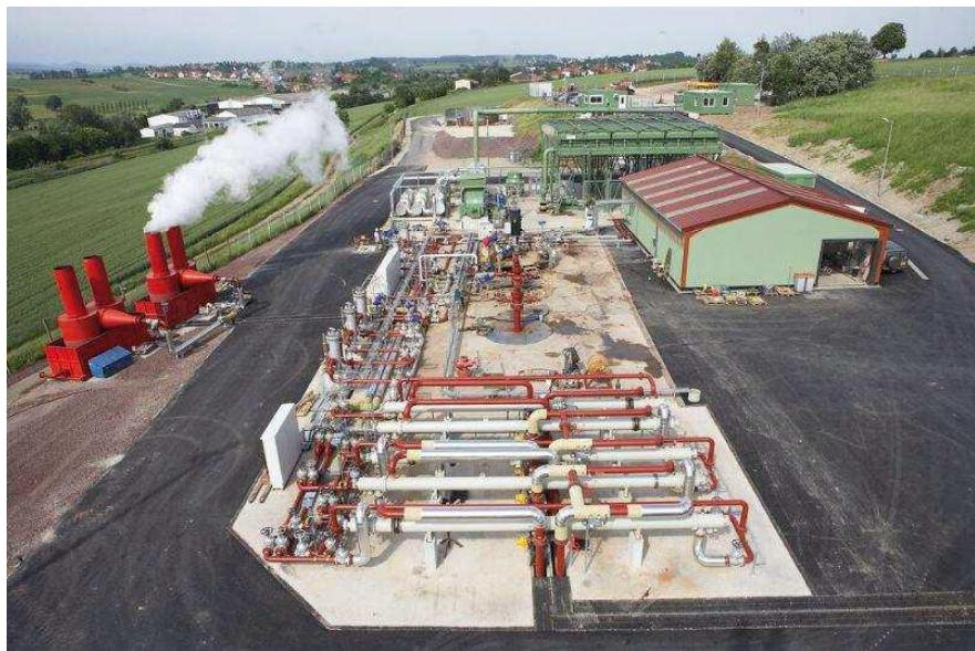
**Slika 5-1.** Geotermalna stanica Soultz: jedinica za napajanje (u pozadini), 3 geotermalne bušotine (u sredini), geotermalna petlja za hlađenje (naprijed) (FinalReport EGS Pilot Plant, 2009.)
