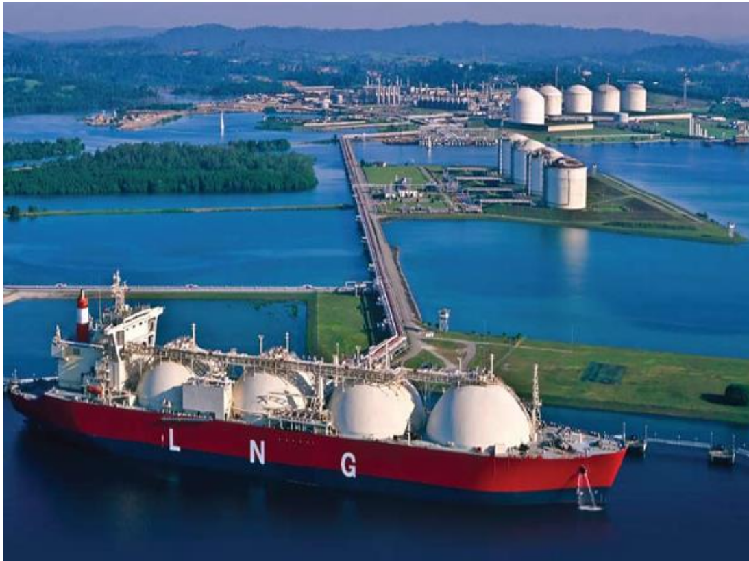
Slika 2-3. UPP tanker na Bontang LNG terminalu za ukapljivanje ( www.geology.com )
