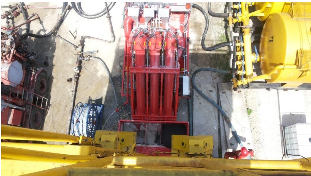
Slika 2.5. Pogled sa silosa za podupirač (Škrinjarić, 2015)
