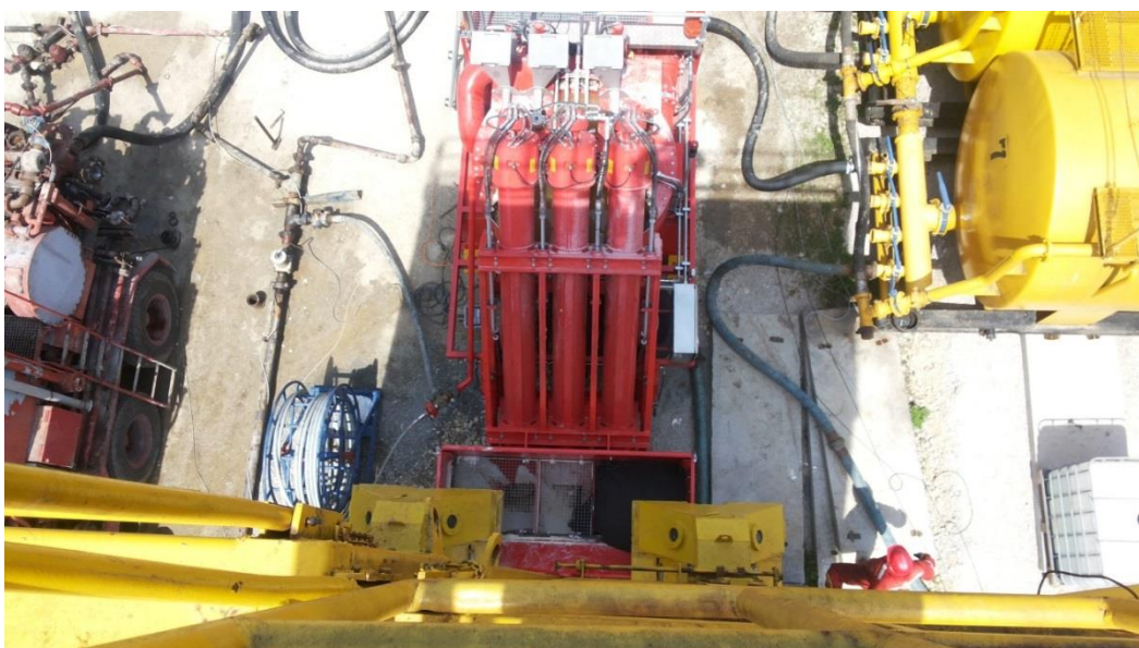
Slika 2.5. Pogled sa silosa za podupirač (Škrinjarić, 2015)
