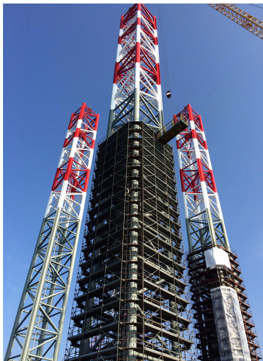
Slika 5-10. Noge nakon obnove (Crosco, 2015c)
