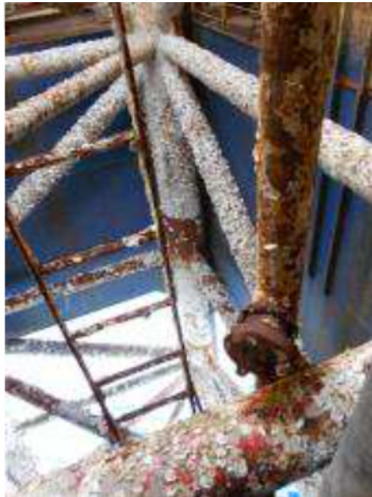
Slika 5-11. Dotrajali mlazni cjevovod (Crosco, 2015c)
