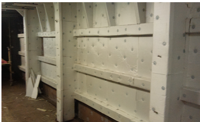
Slika 5-7. Izoliranje pregrada prije ugradnje glavnog sklopnog bloka (Crosco, 2015c)
