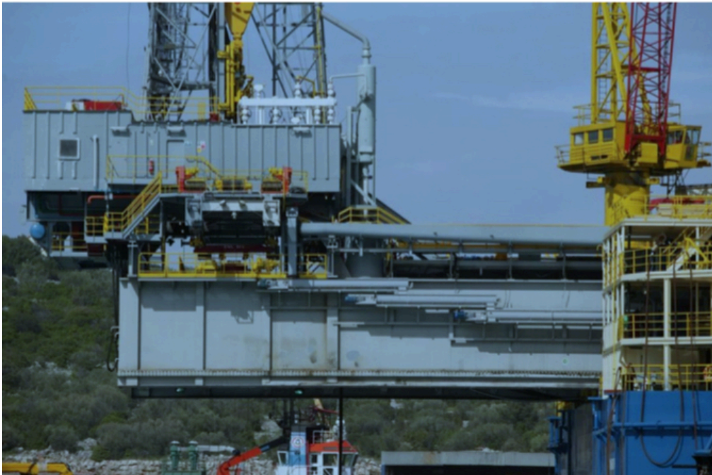
Slika 4-4. Postavljanje nove konzolne podkonstrukcije (Zadravec, 2007)
