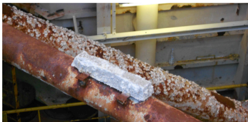
Slika 5-12. Iskorištene žrtvene anode (Crosco, 2015c)
