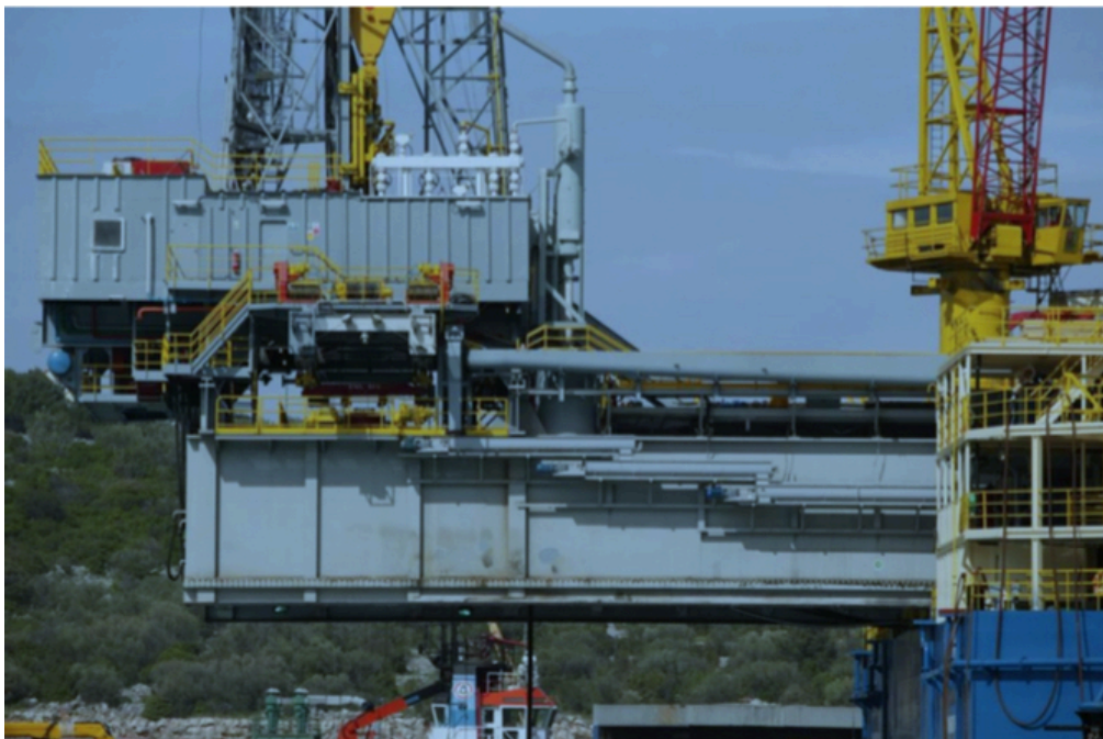
Slika 4-4. Postavljanje nove konzolne podkonstrukcije (Zadravec, 2007)
