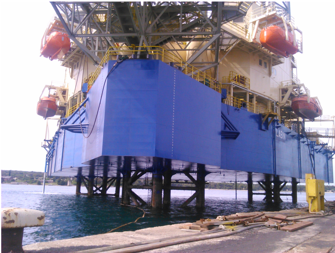
Slika 5-3. Završena ugradnja pramčane ekstenzije (Crosco, 2015c)
