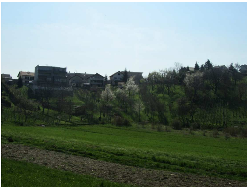
Slika 97 Novi objekt na konkavnoj padini u Lukšićima koji je u funkciji stabilizacije padine. Na terenu nema vidljivih tragova klizanja (snimljeno u proljeće, 2013. godine)
