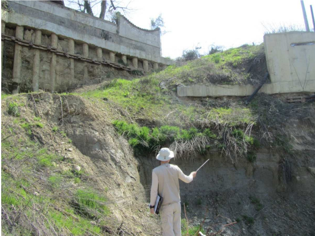
Slika 85 Napušteno gradilište u Kvaternikovoj ulici koje je prouzročilo reaktiviranje klizišta broj 640209 identificiranog prema stereomodelu iz 1964. godine (snimljeno 2013. godine)
