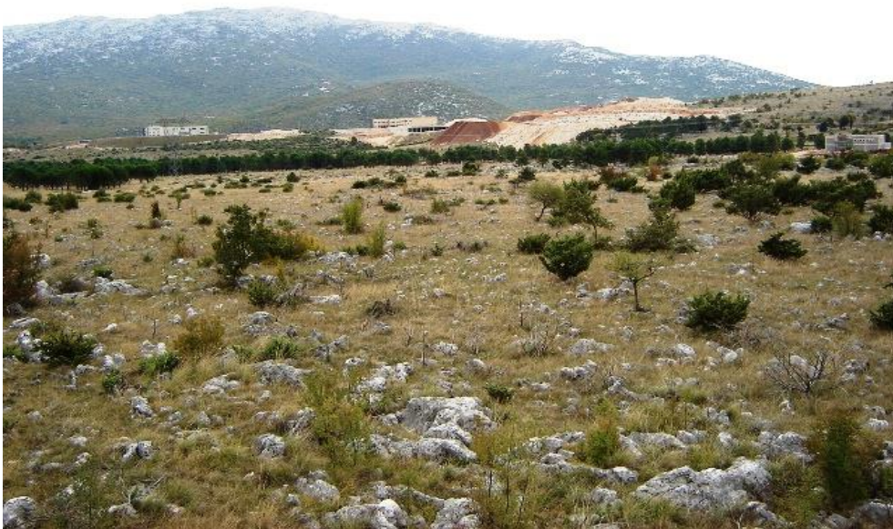
Slika 4.1.5. Gospodarska zona u izgradnji (Foto: Dragana Dogančić).
