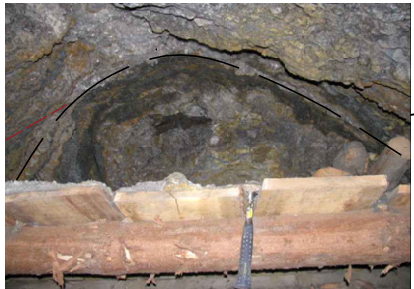
Kontaktna zona/rasjedi strop, 12 m
