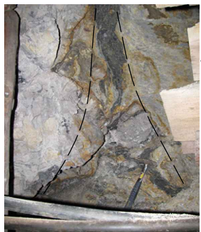
Račvanje dvaju rasjeda, lijevi bok i strop, 12 m
