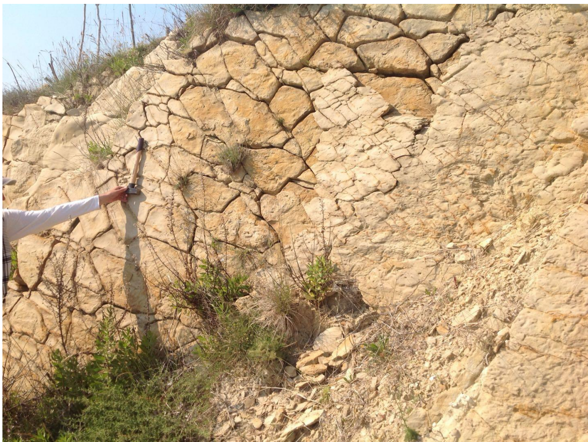
Slika 4–13. Prikaz setova pukotina unutar fliša
