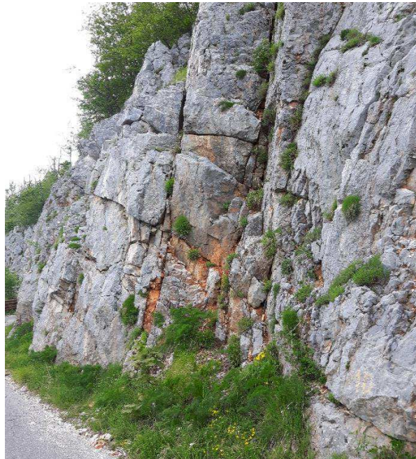
Slika 5-13. Izdanak nedefinirane jedinice Gornji kalciferski vapnenac s razvijenim setovima pukotina kod točke C 7 .
