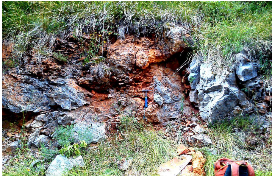
Slika 5-3. Crvena glinovita ispuna u pukotinama stijena jedinice Sis na točki opažanja F9.
