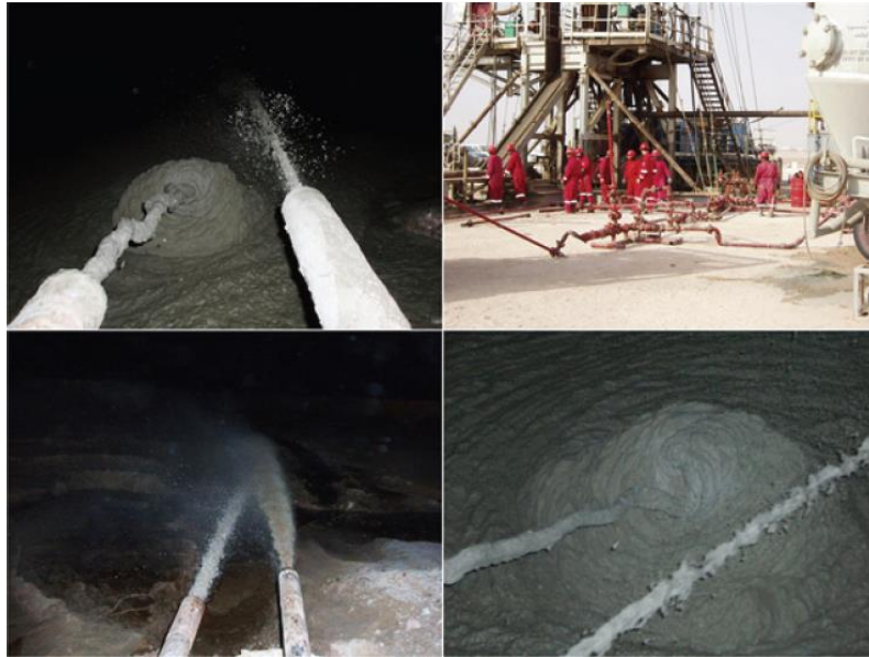
Slika 5-24. Prikaz slike postrojenja i povrata pjencementne kaše na površinu (Weerd i dr., 2010)
