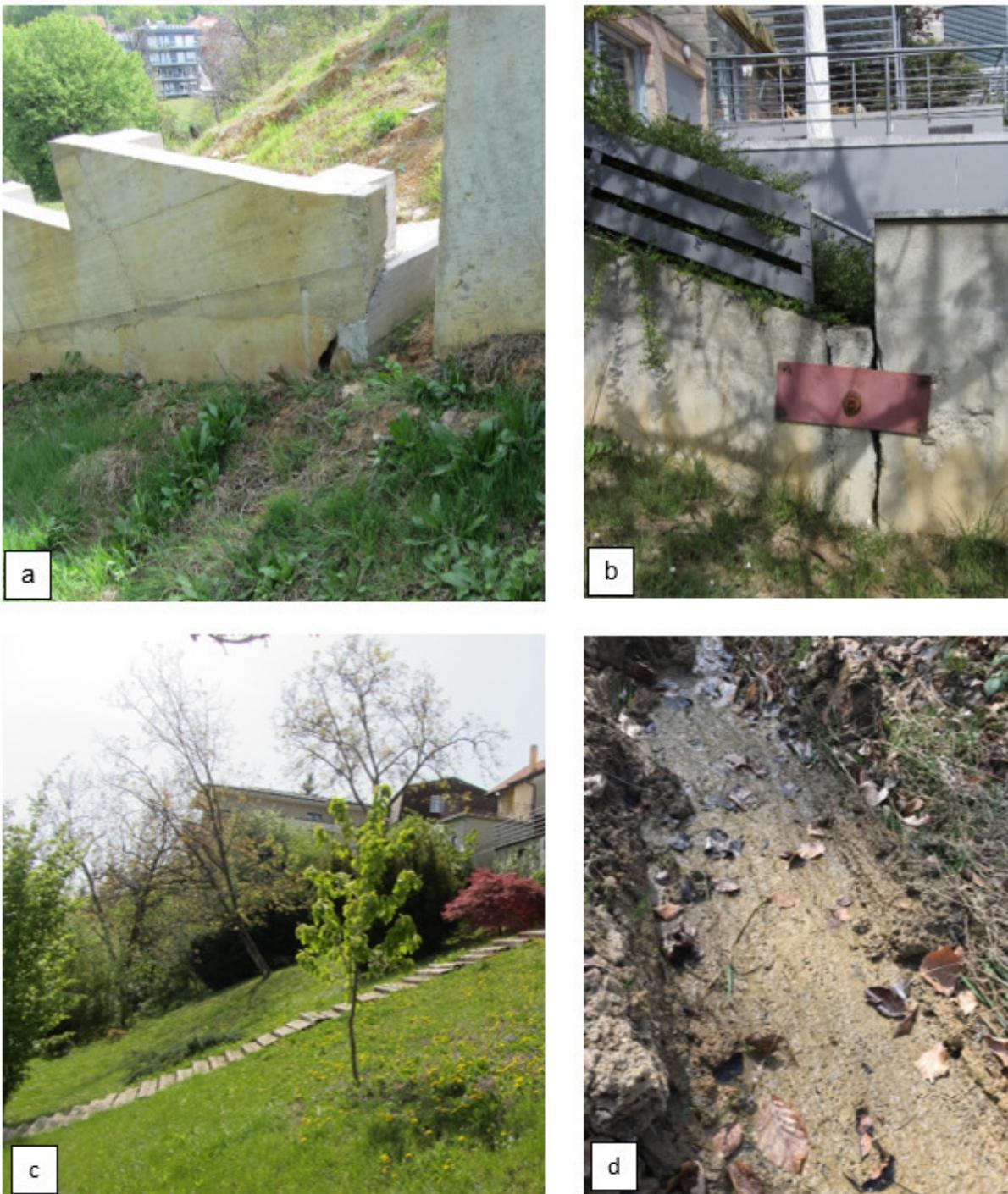
Slika 3.2 Klizište Pantovčak (fotografirano 12.04.2017.): puknuće betonskog zida (a); betonski zid pričvršćen željeznom konstrukcijom (b); "pijano" drveće (c); vlažno tlo (d).
