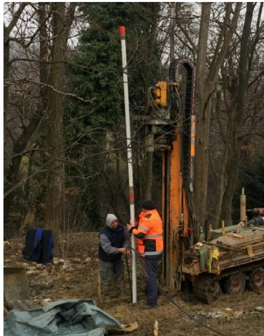
Slika 3.4 Ugradnja inklinometra u bušotinu B-4.
