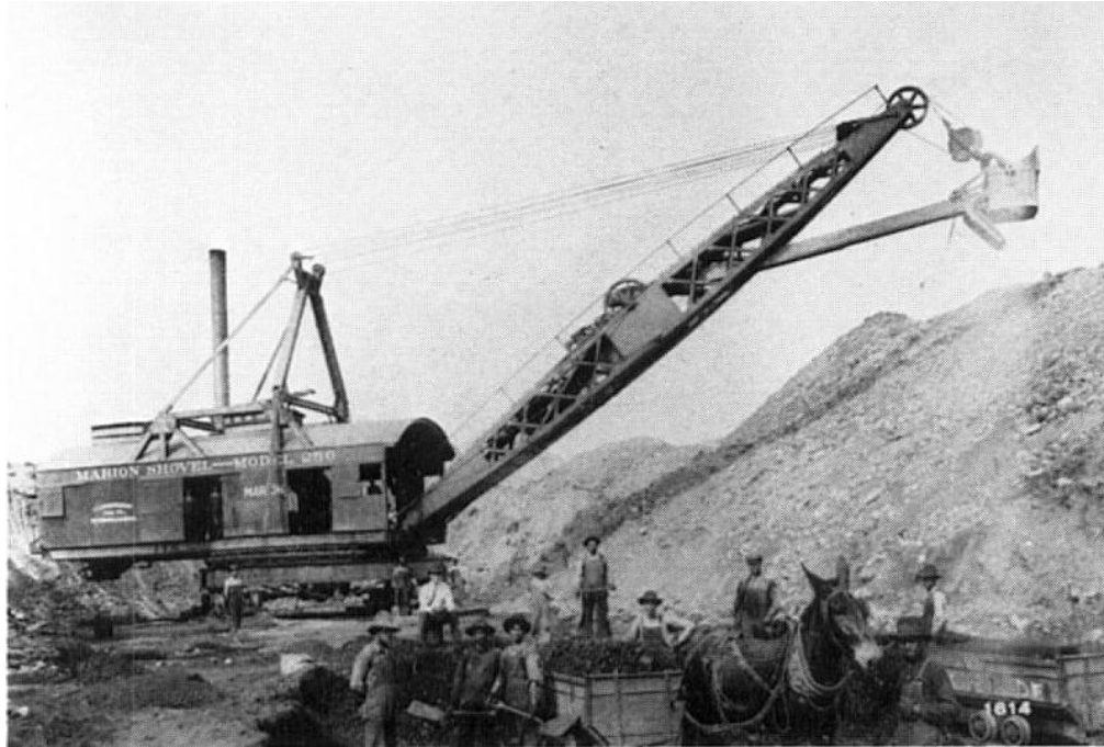
Slika 2-2. Bager s visinskom lopatom tvrtke „Marion“ (Kujundžić 2015)
