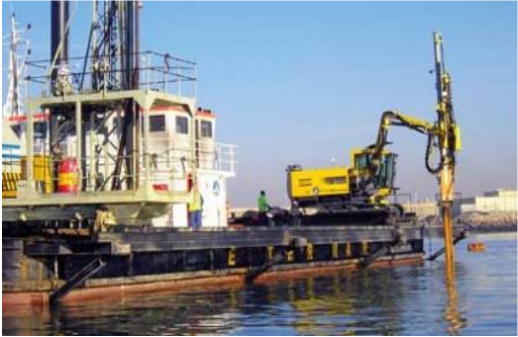
Slika 2-1. – Bušenje minskih bušotina (Miningandconstruction.com)
