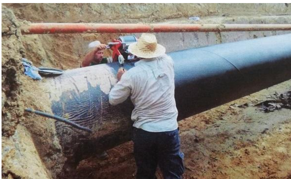
Slika 5-9. Postavljanje antikoroziivne trake (JANAF D.D., 2016)
