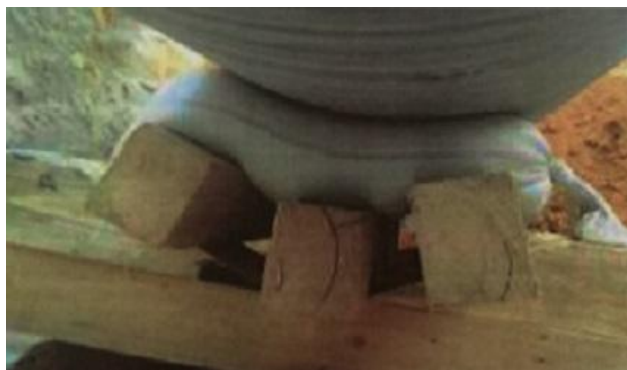
Slika 5-6. Potporanj naftovoda prilikom popravka (JANAF D.D., 2016)
