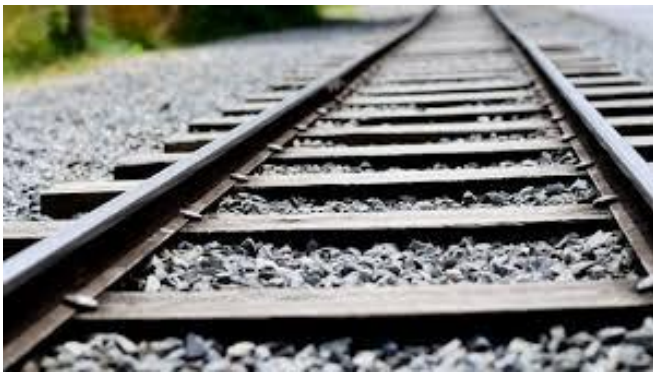
Slika 2-5 Tucanik na željezničkim prugama
