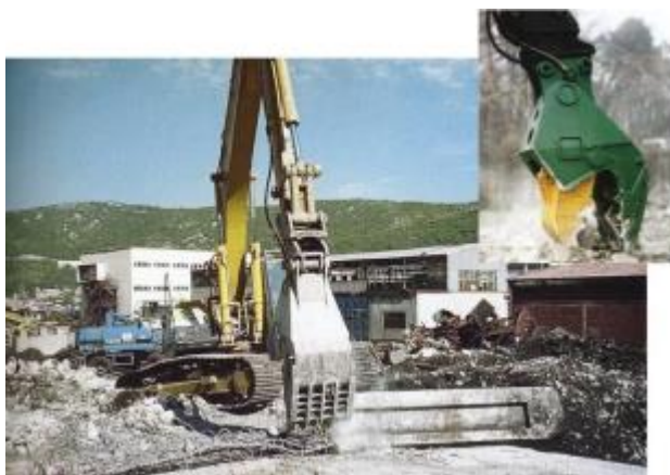
Slika 4-4: Usitnjavanje hidrauličnim škarama (krešerom) (Lovinčić, 2018)
