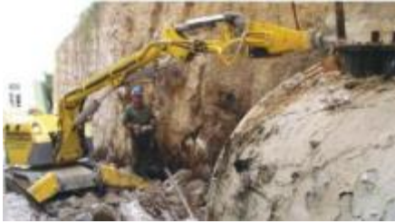
Slika 4-1: rušenje objekata (Lovinčić, 2018)
