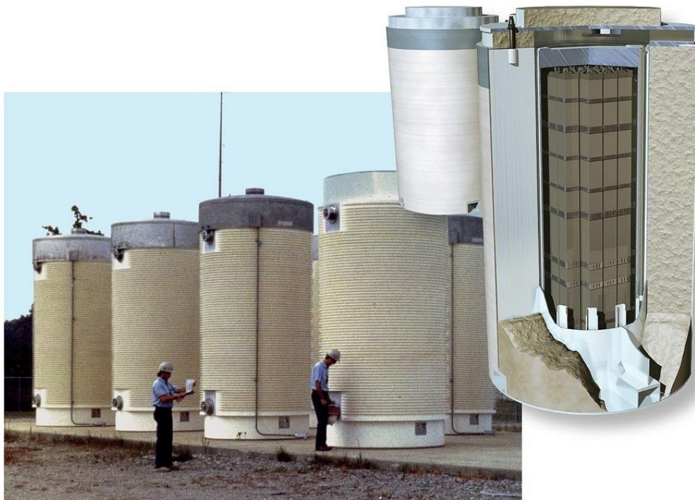
Slika 3-5 Spremnici za suho skladištenje iskorištenog nuklearnog goriva ( https://www.flickr.com/photos/nrcgov/36801710635 )
