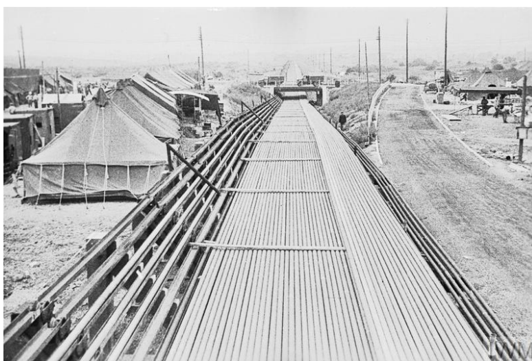
Slika 2-1. Izrada cjevovoda za projekt PLUTO (Imperial War Museums, 2018)
