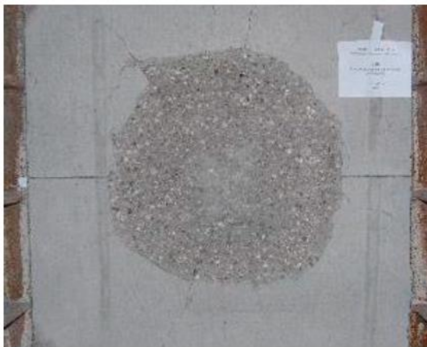
Slika 5-3. Prikaz neopterećene strane betonske ploče izrađene od betona bez vlakana (Zircher i dr., 2017)
