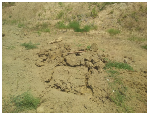
Slika 7.32 Neželjeni lijevak u obliku kratera
