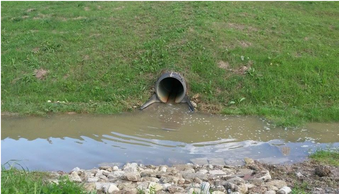
Slika 3-6. Obodni kanal i drenažna cijev
