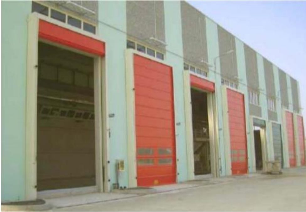
Slika 4-8: Rolo vrata prijemne jame za prihvat otpada u MBO postrojenje (IPZ Uniprojekt TERRA d.o.o., 2011.)
