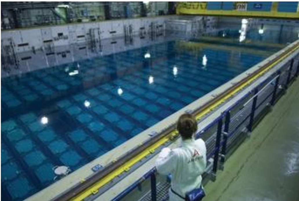
Slika 2—2 Skladištenje u bazenu s bornom vodom u La Hague, Francuska (Nuclear engineering international, 2018)
