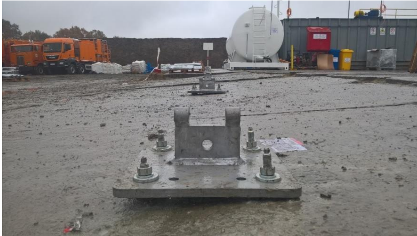
Slika 3-1. Bazna ploča šatora (Crosco, 2017b)
