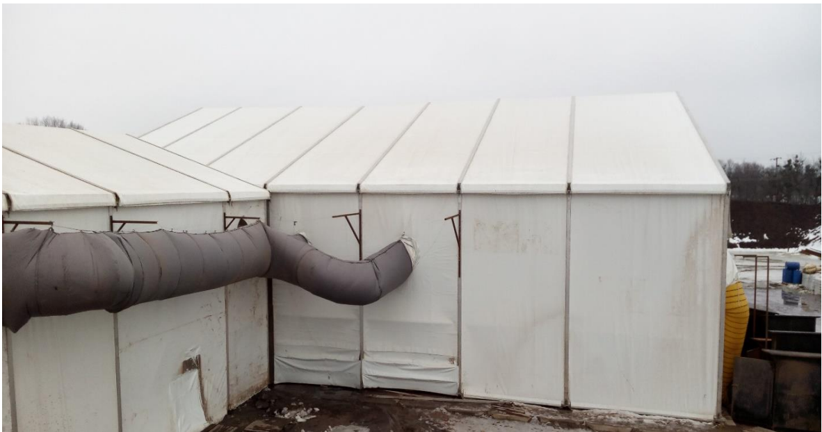
Slika 3-6. Tekstilne cijevi uljnih termogena (Crosco, 2017b)
