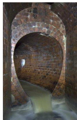
Slika 6-15 Ovalni oblik presjeka tunela (Primorac, 2019.)
