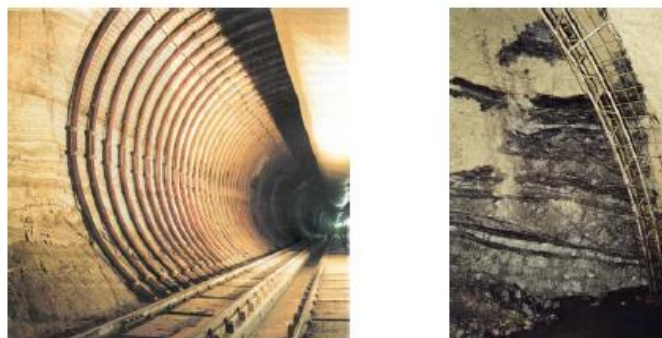
Slika 5-15 Čelični lukovi (Vrkljan,2013.)
