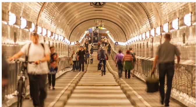
Slika 6-18 Svodasti oblik presjeka tunela (Primorac, 2019.)
