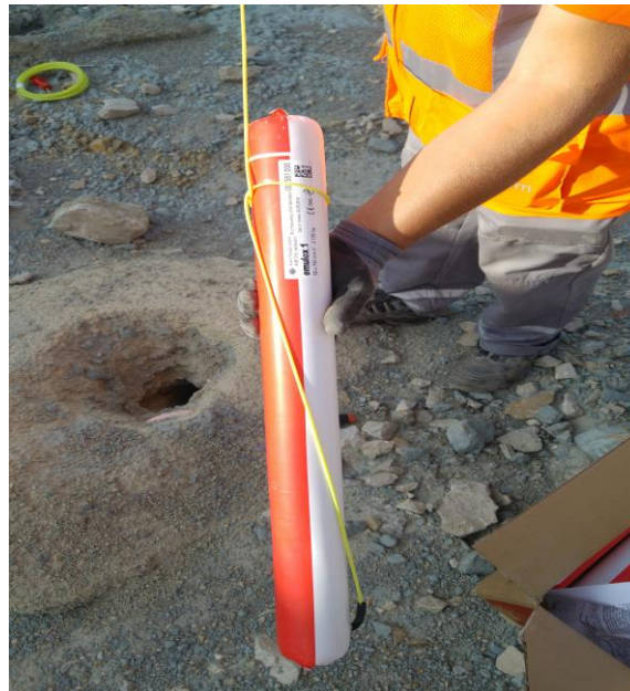
Slika 5-1 Udarna patrona - Emulex 1 eksploziv
