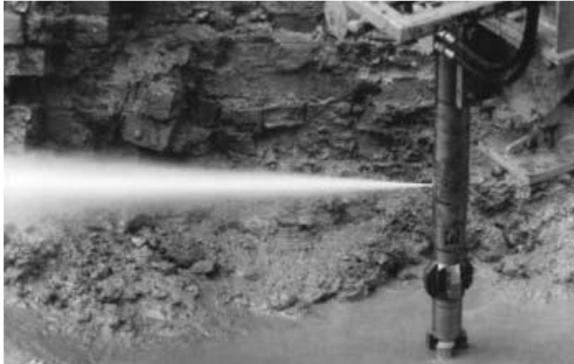
Slika 2-11 Mlaz iz mlaznice na bušaćoj šipki (Dimitrios Kolymbas, 2008)
