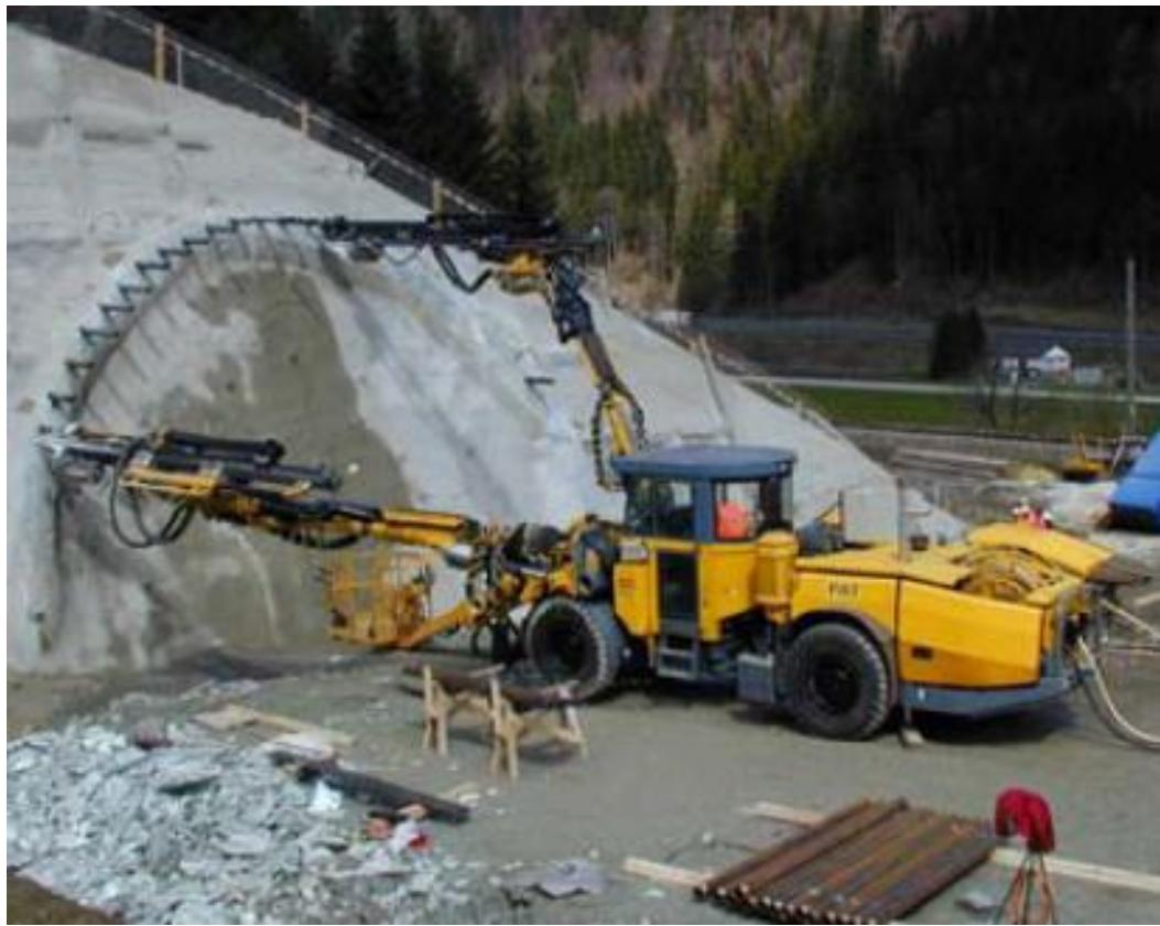
Slika 2-4 Stroj za bušenje kod metode bušenja sa kućištem (Volkmann & Schubert, 2008)
