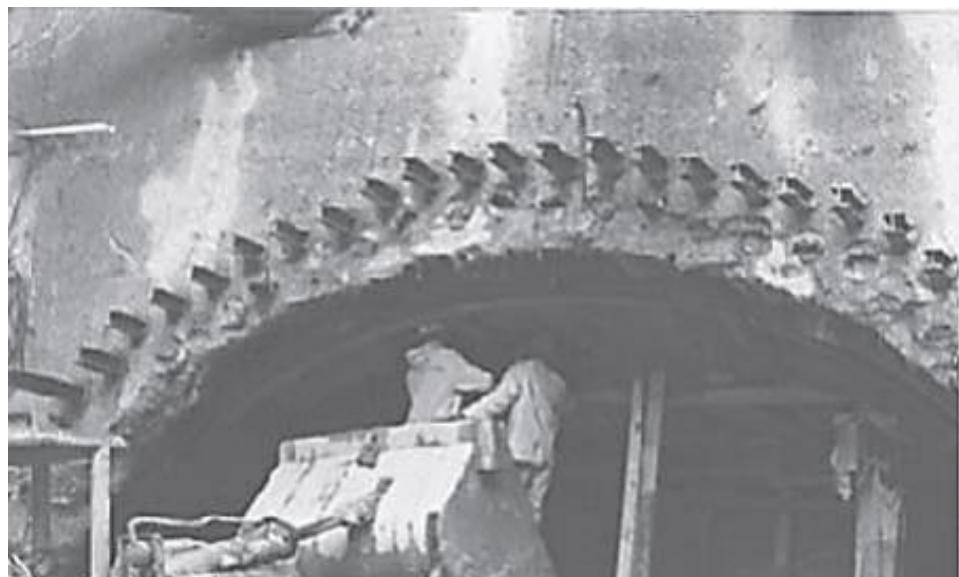
Slika 2-28 Podupiranje iskopa tunela I profilom (Smjernice za projektovanje, građenje, održavanje i nadzor na putevima, 2019)
