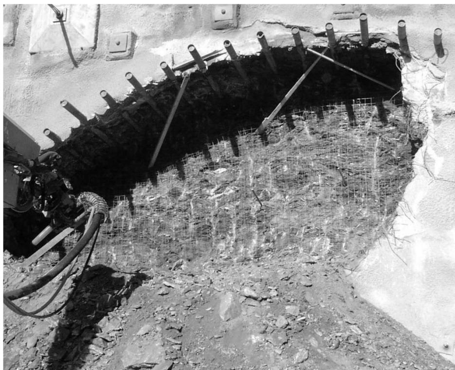
Slika 2-1 Zapadni ulaz tunela Birgl (Austria) podgrađen metodom cijevnih kišobrana (Volkmann & Schubert, 2007.)
