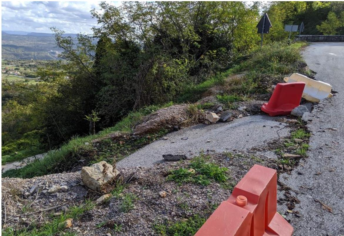
**Slika 3.2.** Prikaz oštećenja prometnice uslijed klizanja, promatrane od SI prema JZ (fotografirano 4.11.2019).
