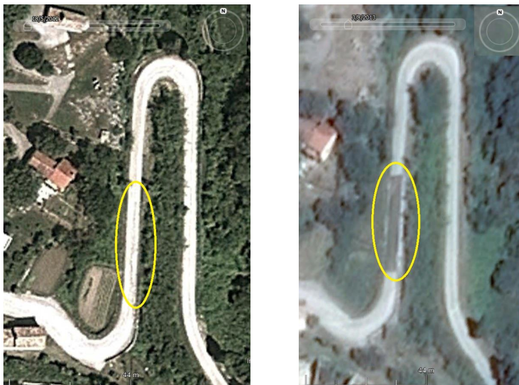
Slika 3.1. Prikaz ortofoto snimka istraživane lokacije: (a) 2012. godine prije oštećenja kolničke konstrukcije i (b) 2013. godine nakon aktiviranja klizišta te popravka oštećene kolničke konstrukcije
