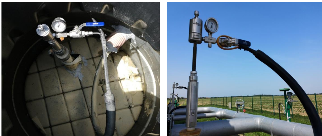
Slika 5-2. Sonda za uzorkovanje koja može biti smještena unutar i izvan šahta
