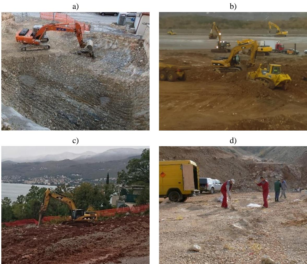
*Slika 5.15. Probna otkopavanja: a) kopanje u Splitu; b) rijanje u Vrbovskom; c) razbijanje u Segetu Donjem; d) priprema minskog polja u Kladnicama (Jug i sur., 2020)*
