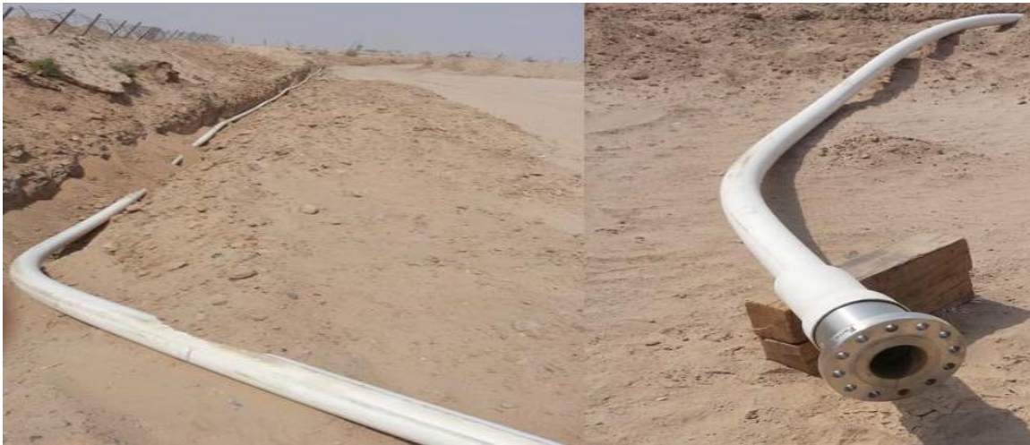
Slika 3-7. Ugradnja termoplastičnih kompozitnih cijevi na naftnom polju Zubair (Cheldi i ostali, 2019)
