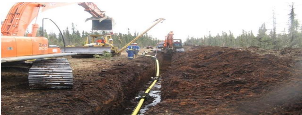
Slika 3-8. Polaganje ojačanih termoplastičnih cijevi u rovove, Sjeverna Alberta (Lesage i ostali, 2010)
