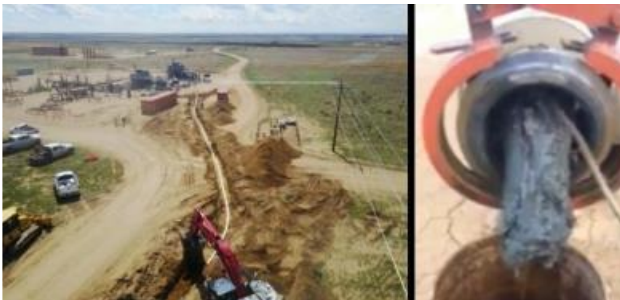
Slika 3-11. Postavljanje ojačanih PA-PERT cijevi promjera 152,4 mm (6") (lijevo) i čepovi parafina u čeličnoj cijevi (desno) (Chang i ostali, 2018)
