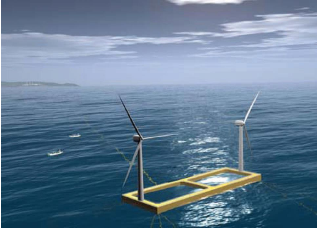
Slika 4-12. NMRI koncept barže (Utsumomiya et al., 2010.)
